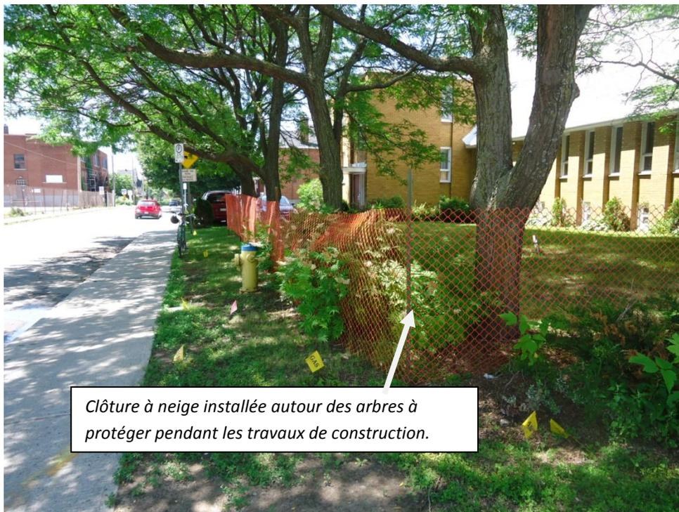
*Clôture à neige installée autour des arbres à protéger pendant les travaux de construction.*
