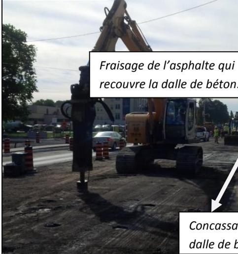
*Fraisage de l'asphalte qui recouvre la dalle de béton.*
