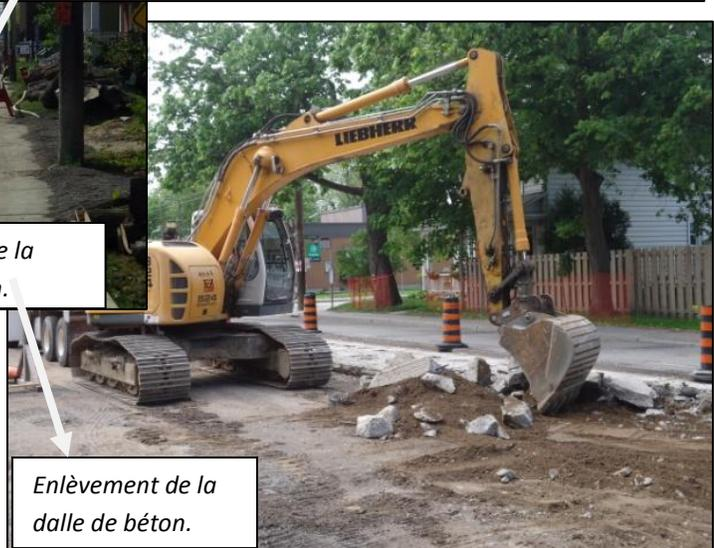
*Concassage de la dalle de béton.*
